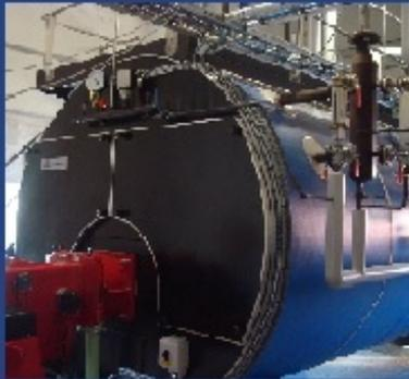
Проектирование и разработка специальных котлов и экономайзеров для рекуперации тепла горячих дымовых газов, происходящих из химических и промышленных процессов. Отработанное тепло выделяют в одно-, двух- и трех-ходовыми пропускными камерами котла, снабженным низкотемпературным экономайзером или со встроенными пароперегревателем в паровых котлах. Производственные мощности до 35 МВт, 55 т / ч пара.
