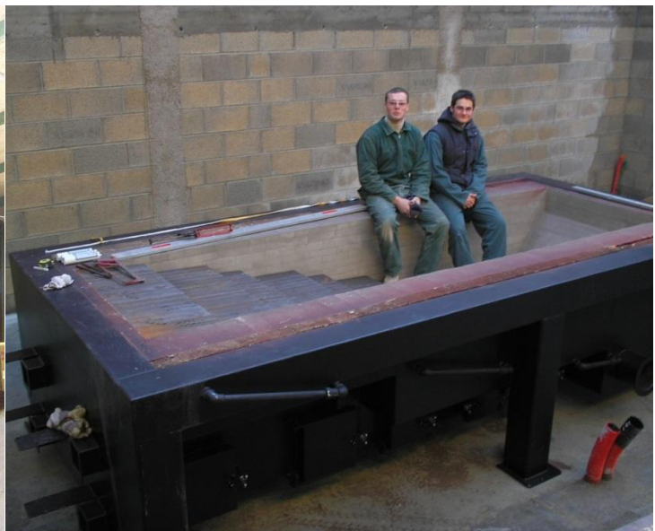
Установка фундаменту котла, паливо - солома
