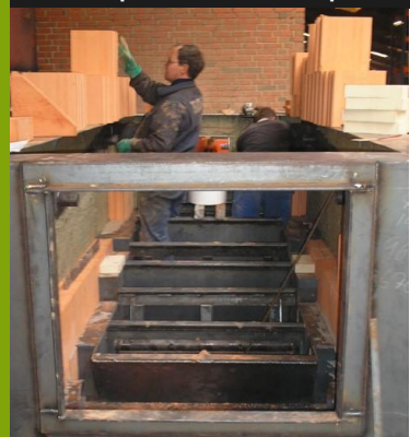
Будівництво фундаменту котла, камера згоряння
